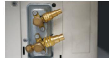
継手を機器の接続オネジに下表の締付トルクで締めてください。
