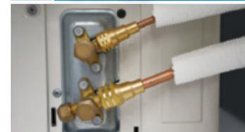
管を継手の奥に当たるまで挿入してください。管挿入後、継手が規定の締付トルクで締付けられていることをトルクレンチで確認してください。
