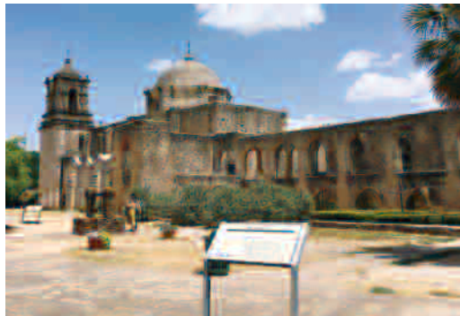
写真1 サンホセ修道院
